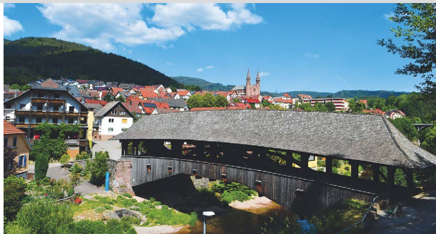
Alte Holzbrücke über die Murg in Forbach.
